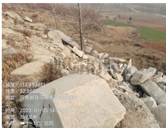
照片 4-7 土地资源压占破坏
