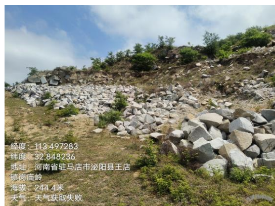
照片 4-6 土地资源压占破坏
